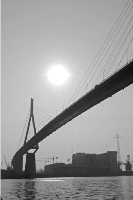
Abb. 1 Die Köhlbrandbrücke überspannt im Hafen von Hamburg einen 300 m breiten Nebenarm der Elbe in 65 m Höhe. Sie ist statisch – nicht reagibel (Photo: www.spahrbier.de)
